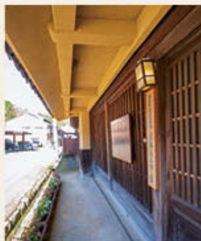
主屋正面外壁（前転び）
