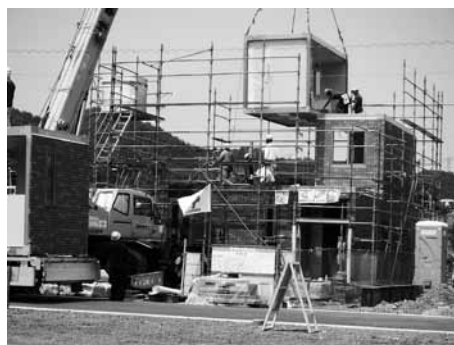
建設中の新築住宅
