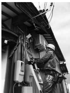
CATVの宅内配線作業
