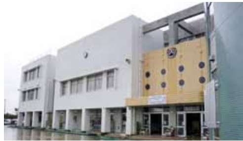
長洲小学校全景
