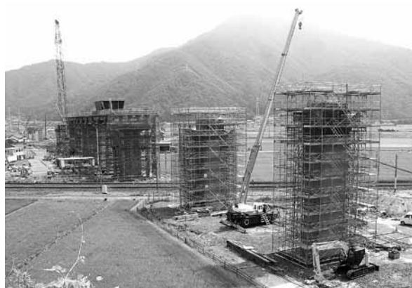
脇本付近の新幹線橋脚
