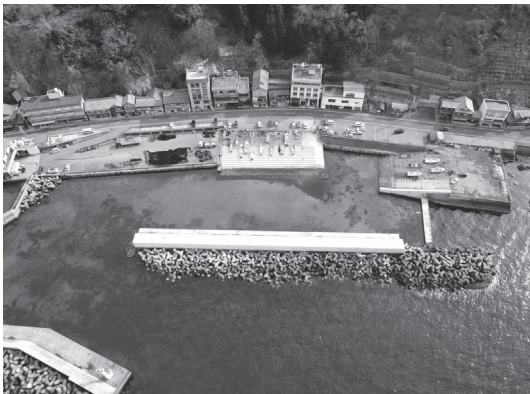
離岸堤嵩上げ工事後の糠漁港
