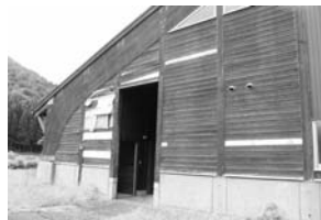
施設の外壁部分
